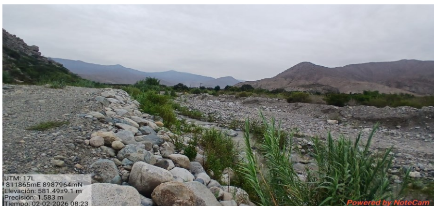
FIGURA N°02.- EN LA FOTOGRAFIA EL DIQUE DE LA MARGEN IZQUIERDA SOCAVADO Y EL DIQUE DE LA MARGEN DERECHO EN BUEN ESTADO.
